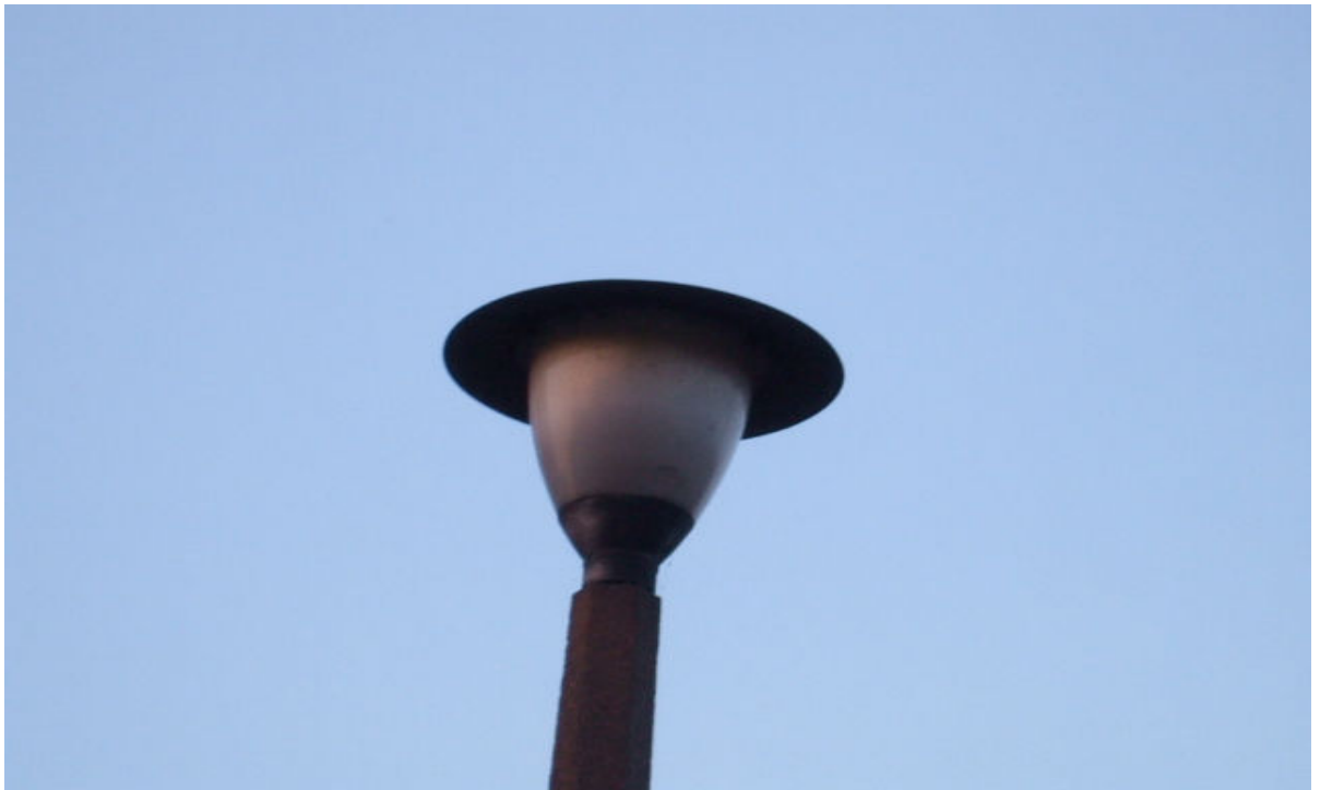
3/7 Mercury Vapour lantern
